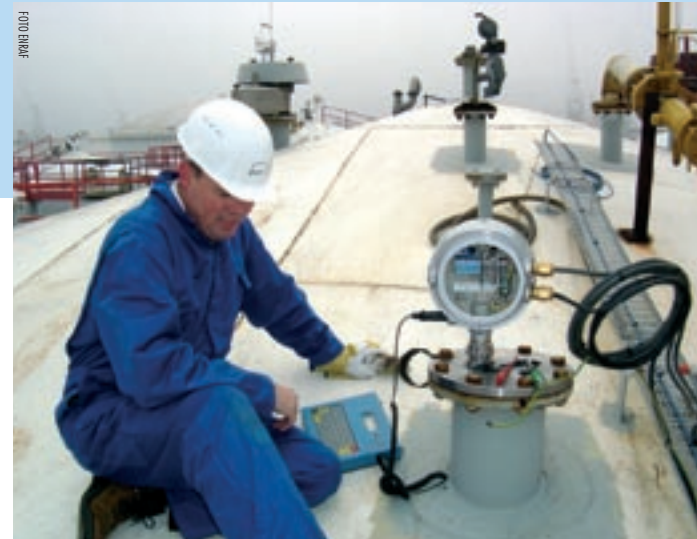
Een monteur van Enraf installeert een radar-niveaumeter op een olieopslagtank.
